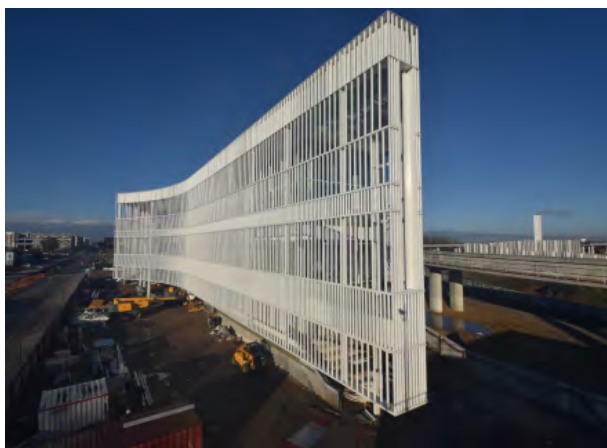
Le chantier du Lumen
